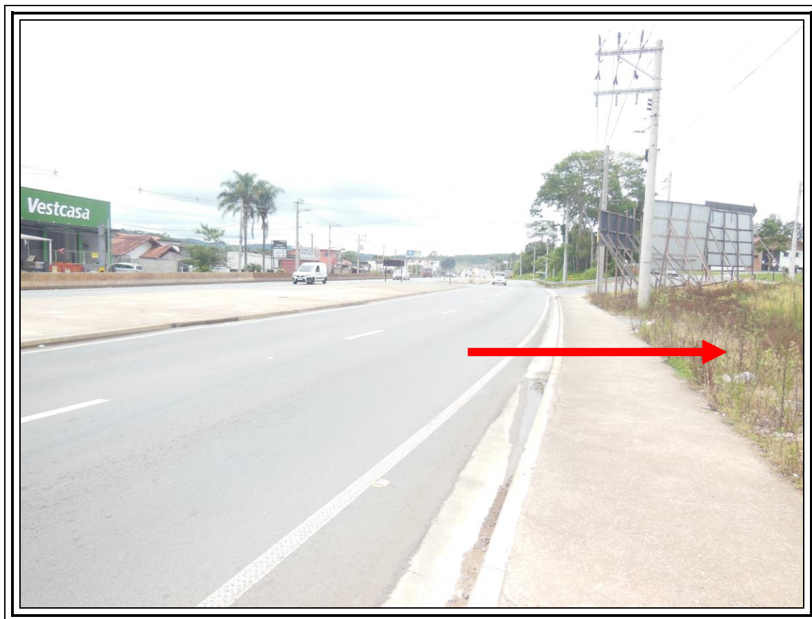
FOTO 01 : Vista parcial da Rodovia Bunjiro Nakao, sentido Ibiúna – Vargem Grande Paulista, km 47, notando-se, à direita, o imóvel avaliando, onde apontado.
