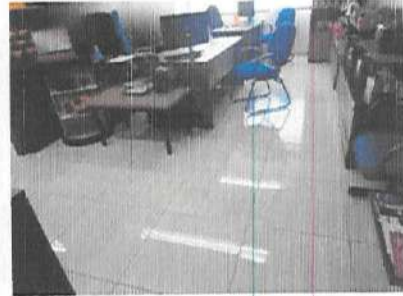
DETALHE PISO EM BOM ESTADO
