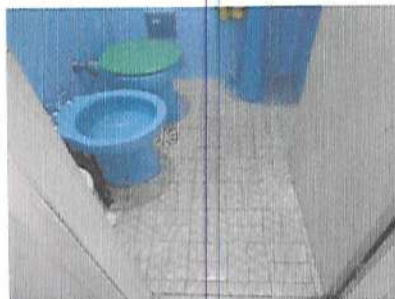
BANHEIRO – DETALHE PISO
