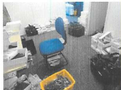
PISO COM REVESTIMENTO DE CARTETE
