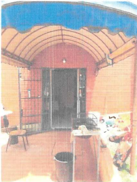
Entrada Prédio administrativo
