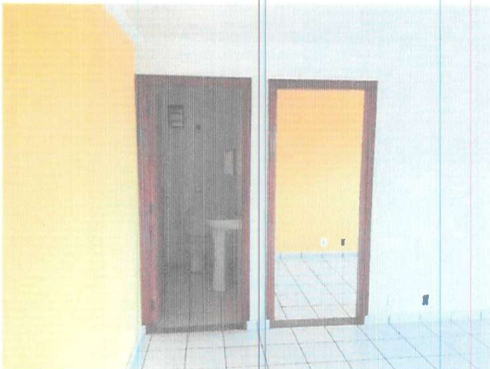
Cômodo 2 – Banheiro e Acesso ao Cômodo 3
