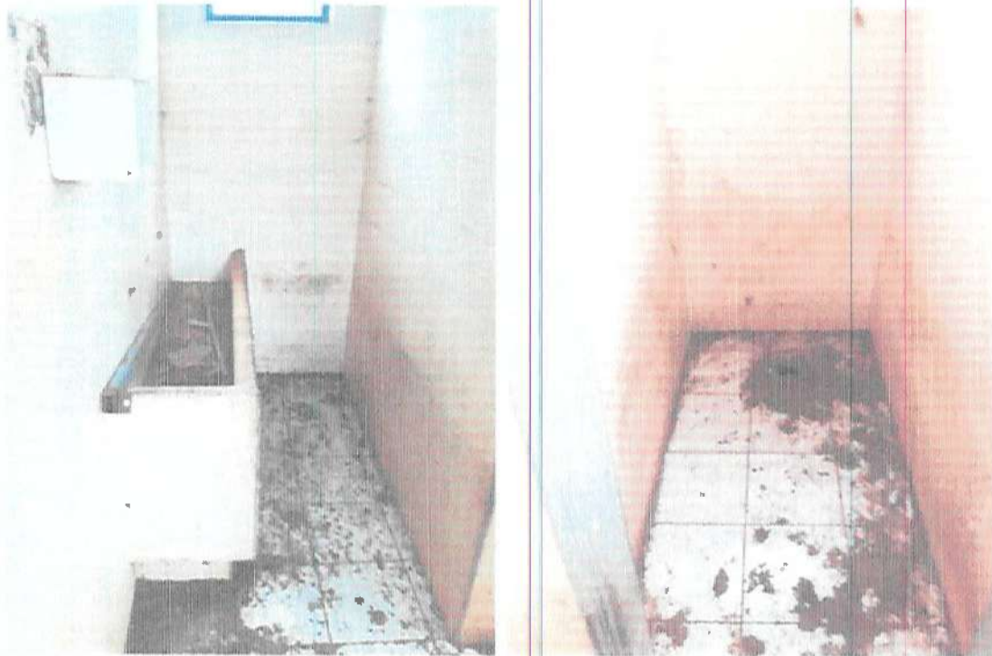
Pia e área de banho do sanitário masculino
