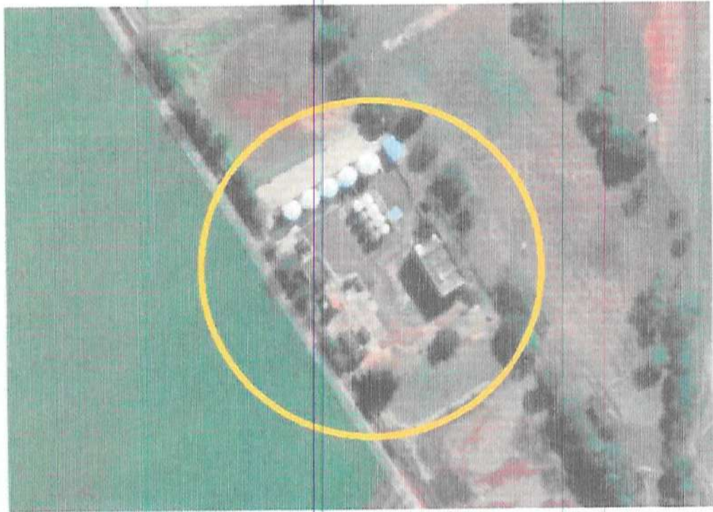
3-Detalhe imóvel Matrícula 4744 - site Google Maps
