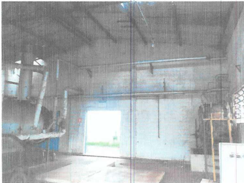
Casa de caldeiras
