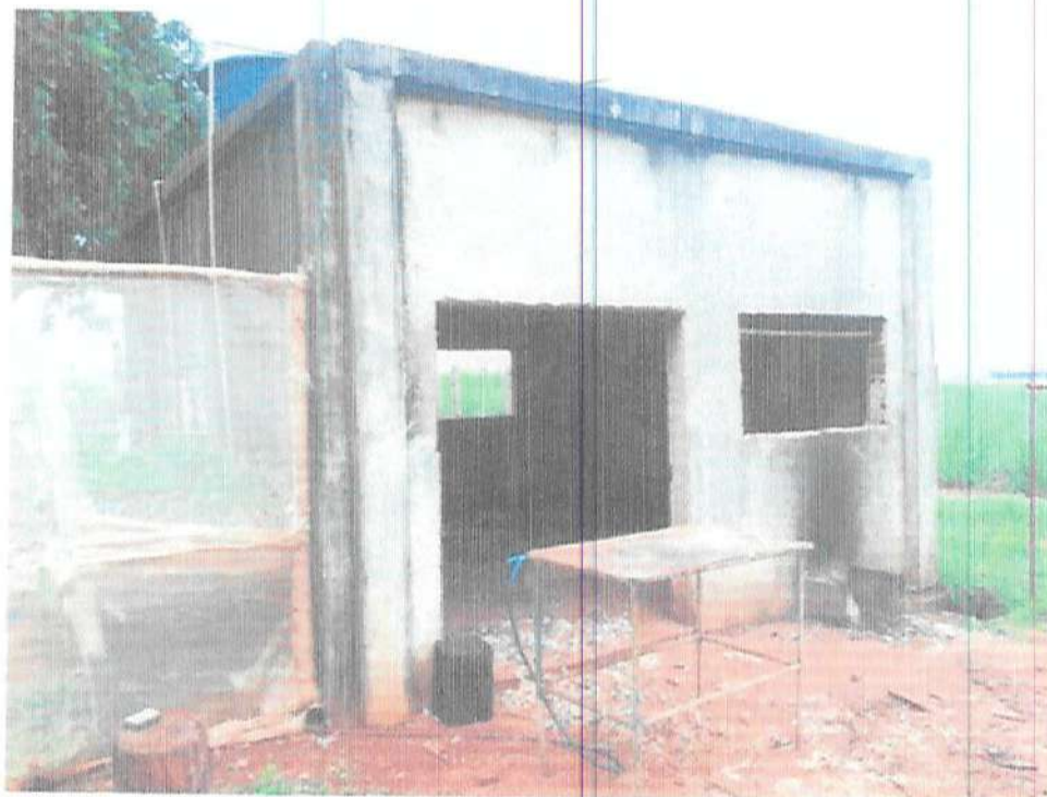
Edificação em construção sem identificação de uso
