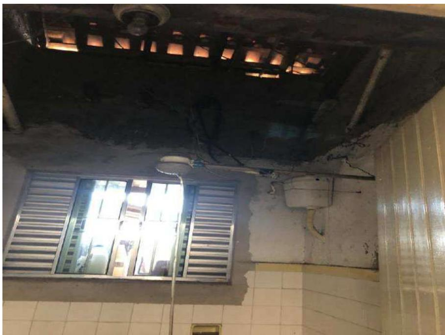
Foto que demonstra o banheiro da casa dos fundos com comprometimento do madeiramento do telhado e do forro por cupins e de todas as instalações (hidráulicas, elétricas e sanitárias).
