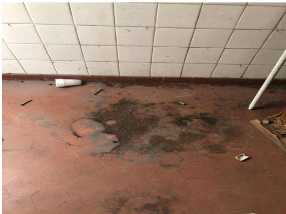
Destaque para o péssimo estado de conservação da construção dos fundos comprometida por cupins e pelos graves sinais de umidade nas paredes e nos forros, além do comprometimento das instalações.
